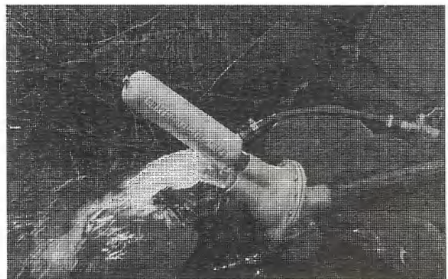
Installation d'une pompe à bélier hydraulique.
